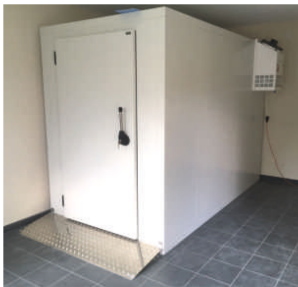
Leichenkühlzelle zur Lagerung von 2 Särgen mit Sargtransportwagen
